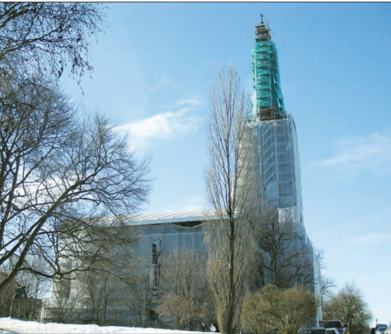
FIRE. I stedet for ett spir måtte det settes fire spir som hver skal tåle 1000 kg. Totalt utgjør Haki-stillasene ca 10 000 kvadratmeter.
